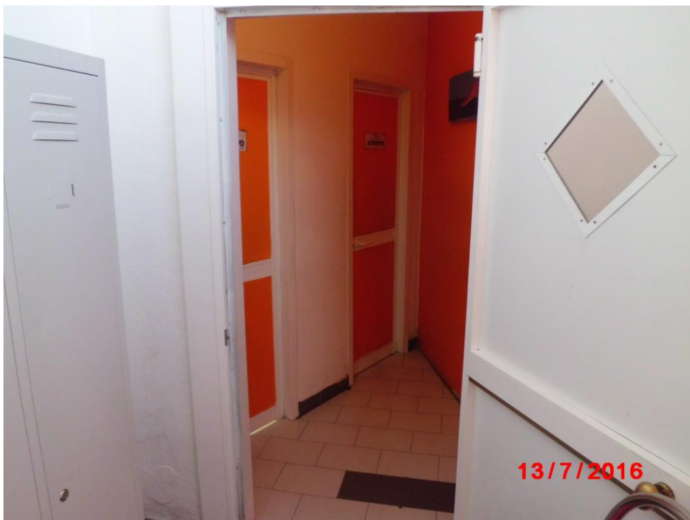
foto 2 – (interni) servizi igienici
