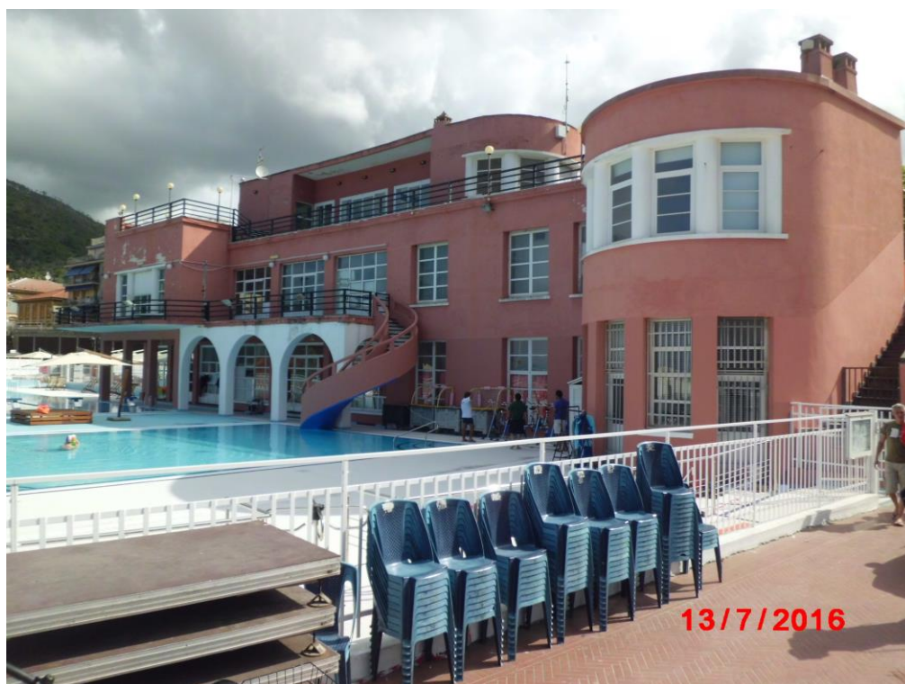
foto 6 – (esterni) vista d'insieme da sud-est
